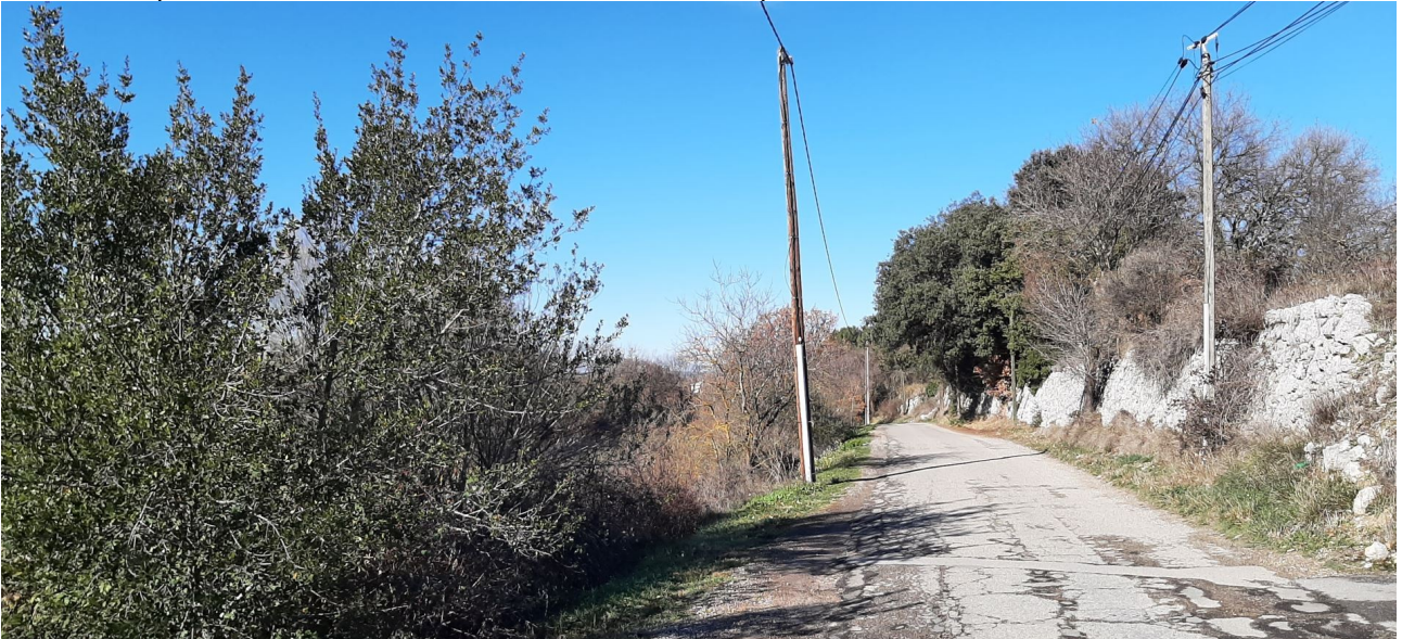
Photo 8 : vue sur le chemin du Budéou. Les cordons arborés, en limite gauche et droite, pourront être impactés par les travaux de raccordement de ce chemin.
